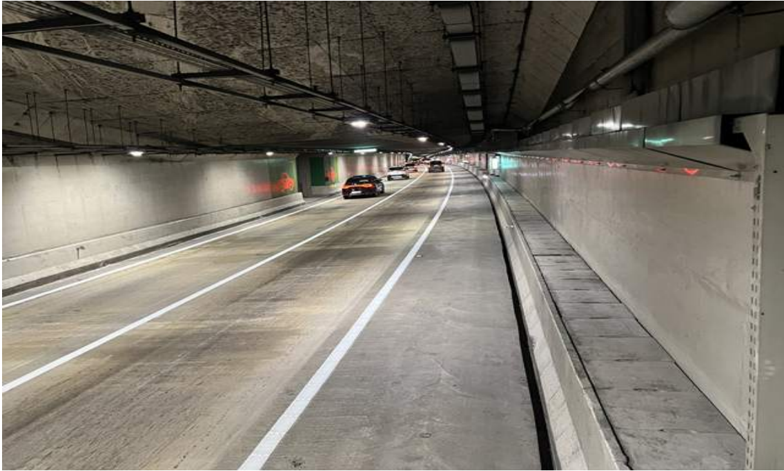
BOX구간 내부 전경
