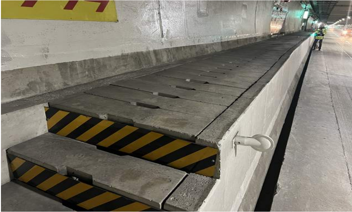
NATM구간 공동구 전경
