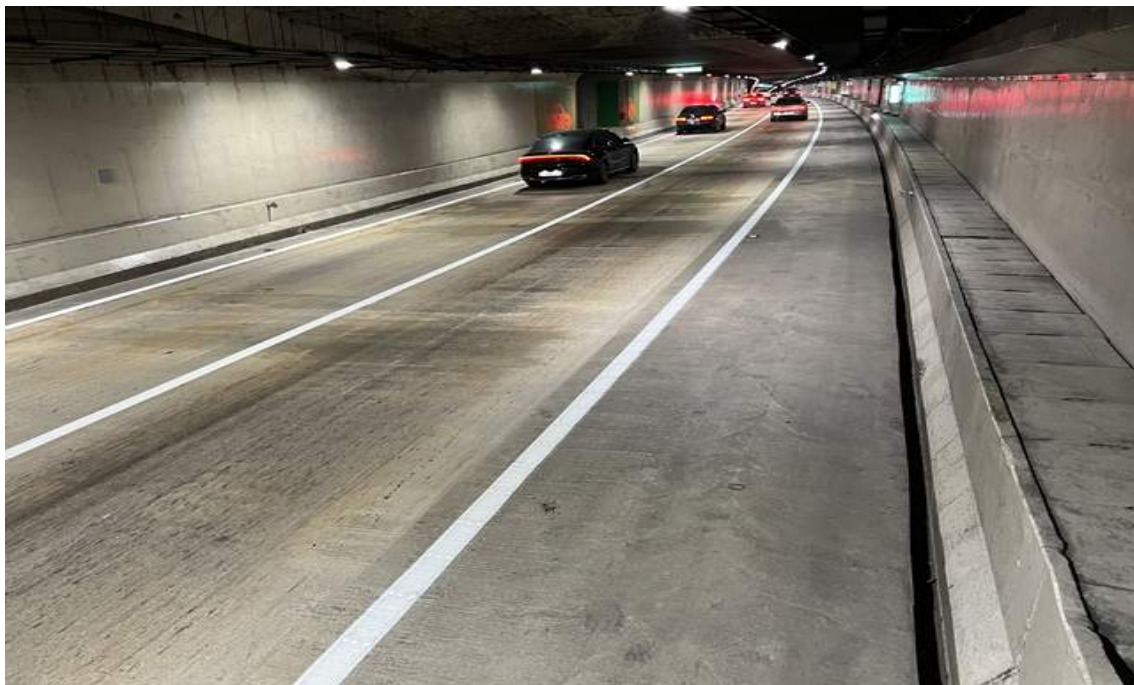
BOX구간 포장 전경
