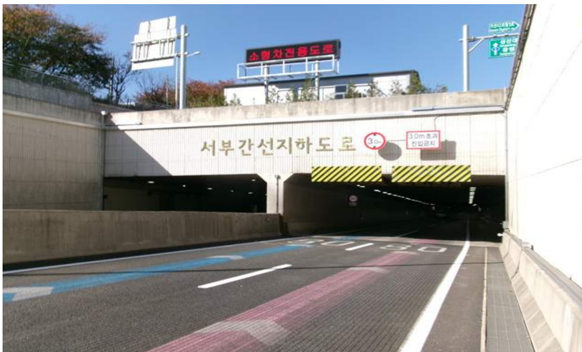
성산방향 갭문 종점부 전경
