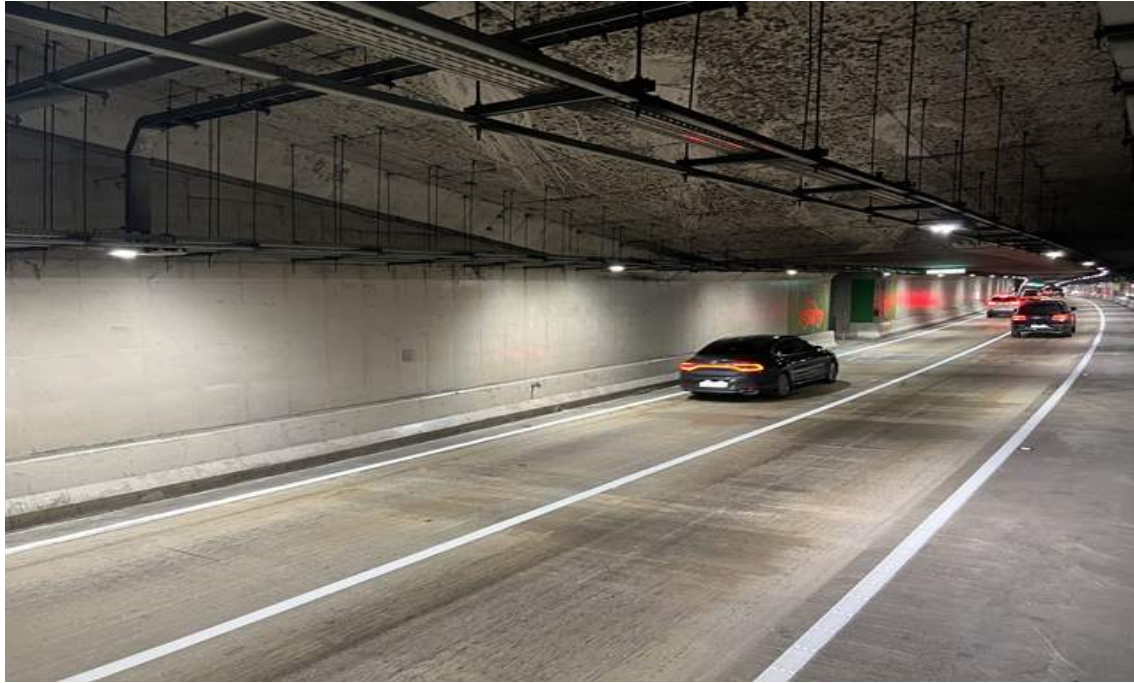
BOX구간 벽체 전경
