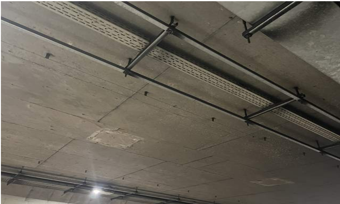
BOX구간 슬래브 전경
